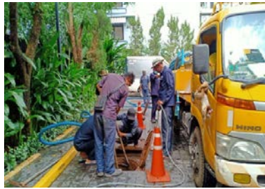
การสูบน้ำก่อนจากระบบบำบัดน้ำเสีย
