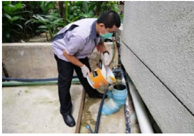
การเติมจุลินทรีย์ลงในระบบ บำบัดน้ำเสีย
