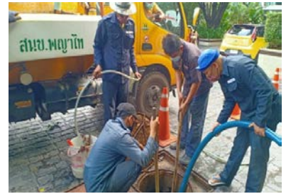
การสูบน้ำก่อนจากระบบบำบัดน้ำเสีย
